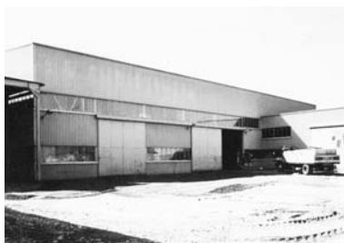
Til venstre: Det tidligere Verkstedbygget ble oppgradert til laktlager og serviceverksted.
