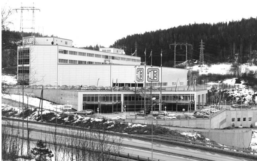
Elkjøp Stork marked Oslo flyttet først til Karihaugen, så i 1999 til nybygget på Tangerud.
